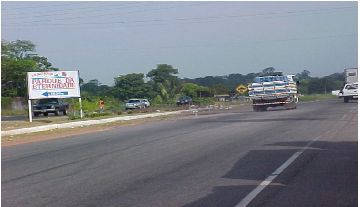
Foto 1: início do trecho restaurado na BR-316 (km 13,4 - estaca 741)
